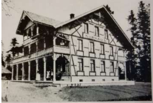
0491 Das neue Kurhaus Waldhäusern um 1910
